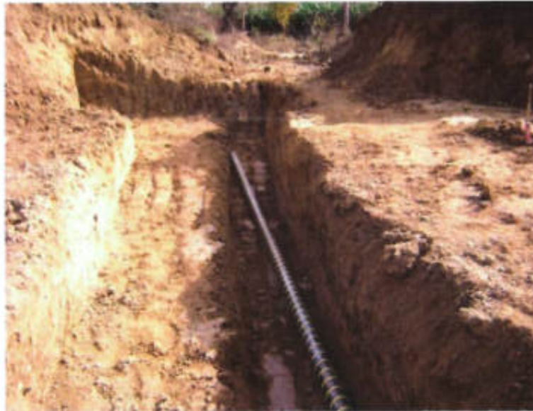
Figura 16 - Attività di scavo
