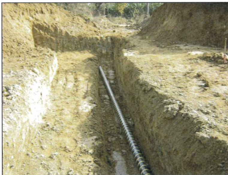
Figura 15 – Attività di scavo
