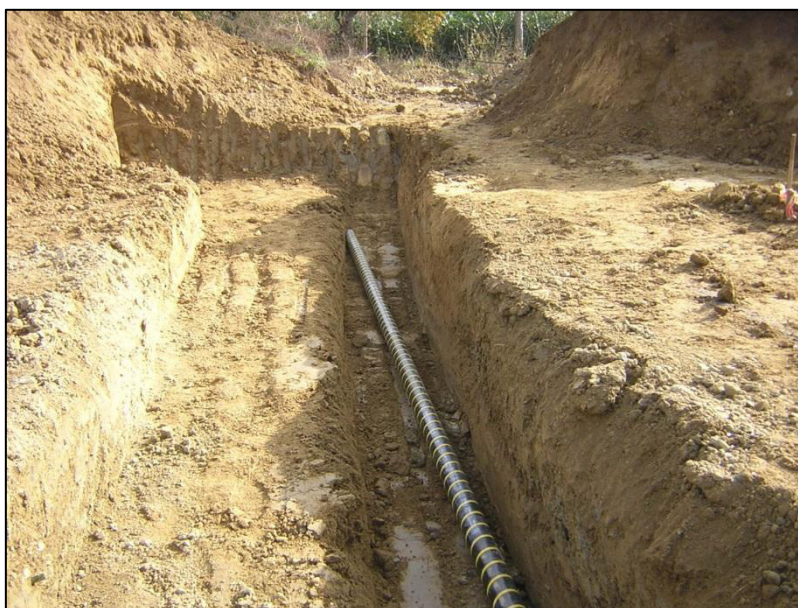
Figura 18 – Attività di scavo
